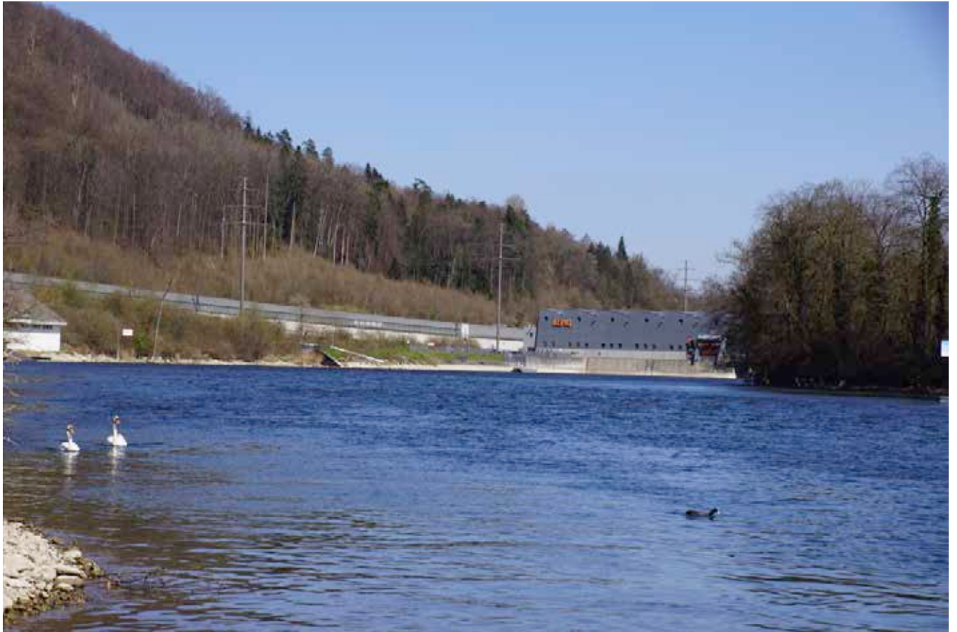
Blick zurück zum Kraftwerk.
